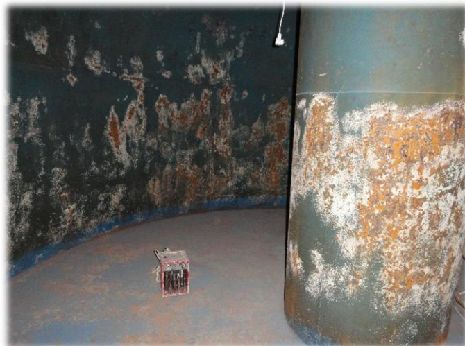
Foto před nátěrem
